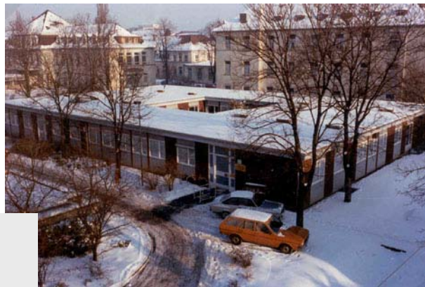
Abb. 1: Das ehemalige Gebäude 105, die "Baracke". Eingang zur Intensivstation. Im Hintergrund rechts die alte Frauenklinik
